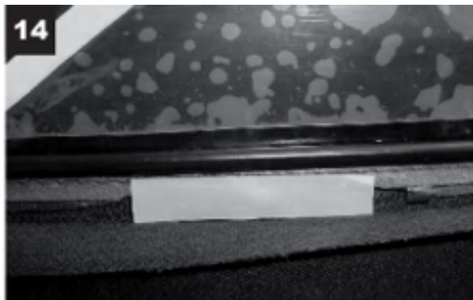
■ Coller sur l'agrafe un ruban d'étanchéité de 100mm affleurant avec le bourrelet profilé et retirer le film sur tout le pourtour.
